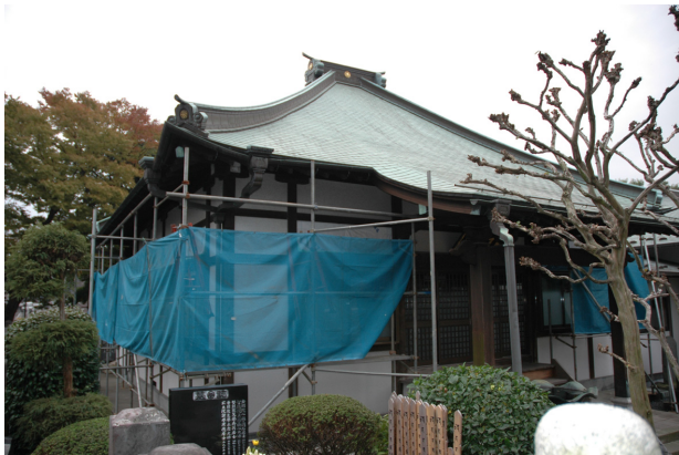
昨年は雨漏りがしないようにブルーシートで覆いましたが、今年は補修工事のシートです。
