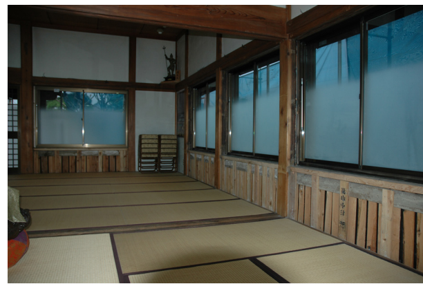
窓枠から雨漏りしないように従来のサッシを取り外し、窓回りを全面改装しています。
