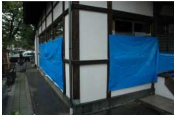
台風23号では直接風雨に曝されないようにシートを準備しましたが、それでも漏水しました。
