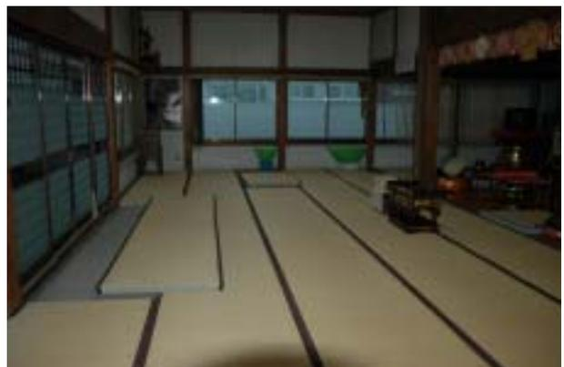
台風22号では北からの暴風雨にさらされ窓枠から漏水しました。畳を上げ水受けを作りました。
